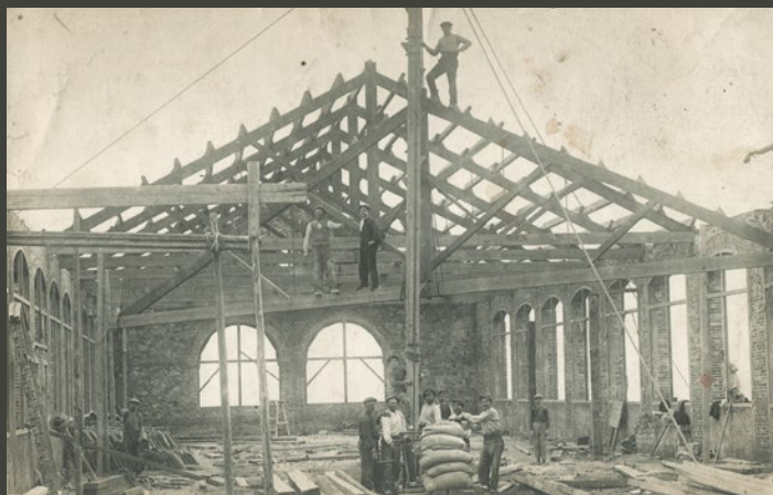
Obrers de l'encavallada de la fàbrica del Sr. Cortès
