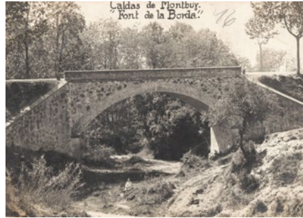
Pont de la Font de la Borda
